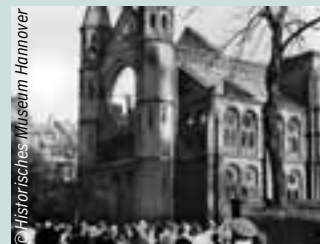
Zerstörte Synagoge in der Bergstraße
